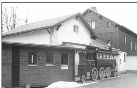
Součástí někdejšího hermsdorfského nádraží je restaurace, hotel, malé muzeum, půjčovna lyží a také spojovací chodba ve tvaru vláčku, připomínajícího slavné časy tehdejší železnice.
