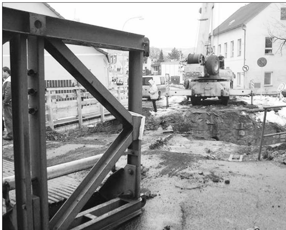
Éra ocelového prozatímního mostu v Dlouhé ulici skončila. V průběhu května ho nahradí zbrusu nová stavba.
