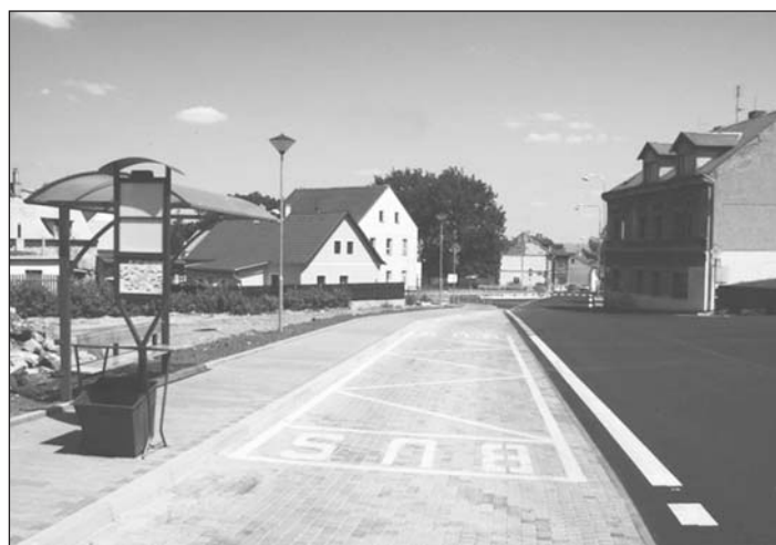
Součástí rekonstrukce bylo i vybudování nové autobusové zastávky.
