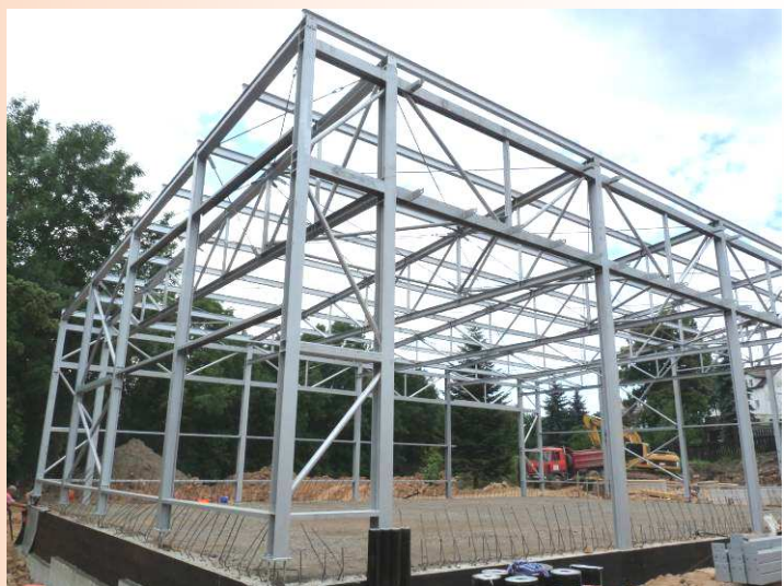
Foto: Konstrukce nové zbrojnice
